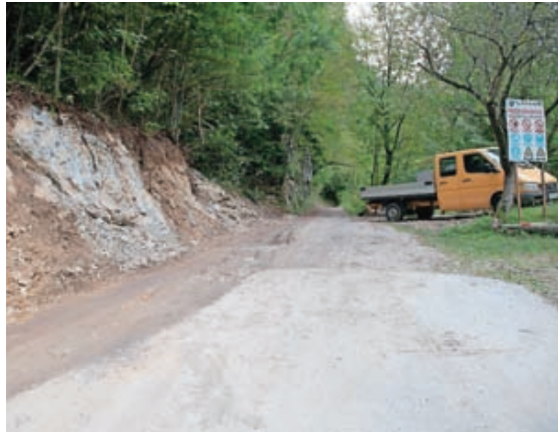
Gradnja kolesarske povezave se je začela na zgornjem delu trase – od Plenšaka v smeri proti staremu delu Železnikov.
